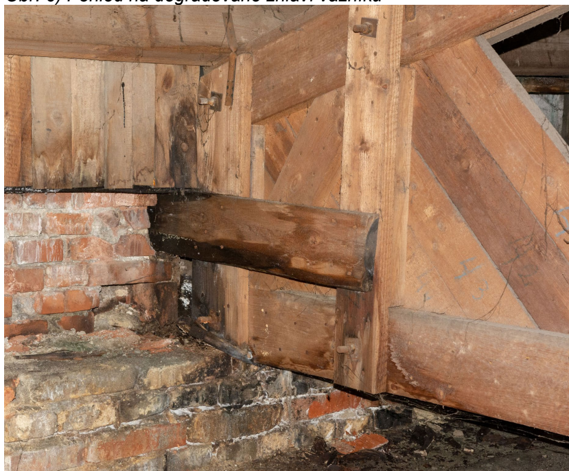
Obr. 6) Pohled na degradované zhlaví vazníku
